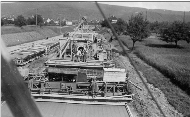
*Große Fertigungsmaschine für Betonbeläge auf der Trasse der A 5 bei Mannheim im Jahr 1935.
