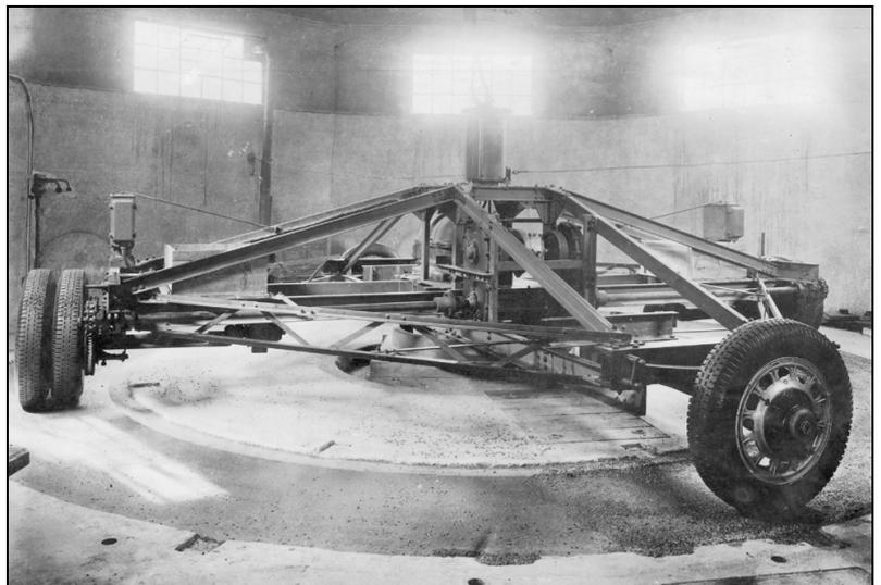
*Im Jahr 1926 wurde eine Versuchshalle zur Prüfung von Straßenbelägen und Rädern eingerichtet. Quelle: Universitätsarchiv Stuttgart 33/1/793*
